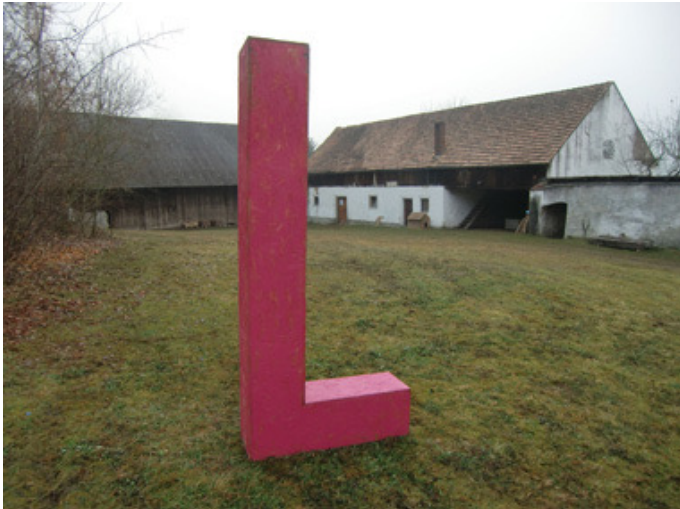
Stadel und Stall, unsaniert
