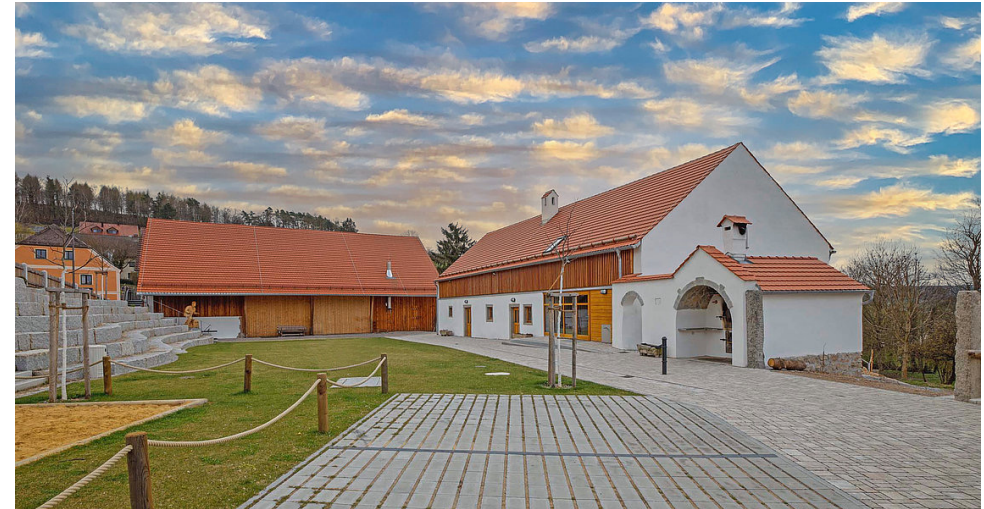
Stadel und Stall, saniert
