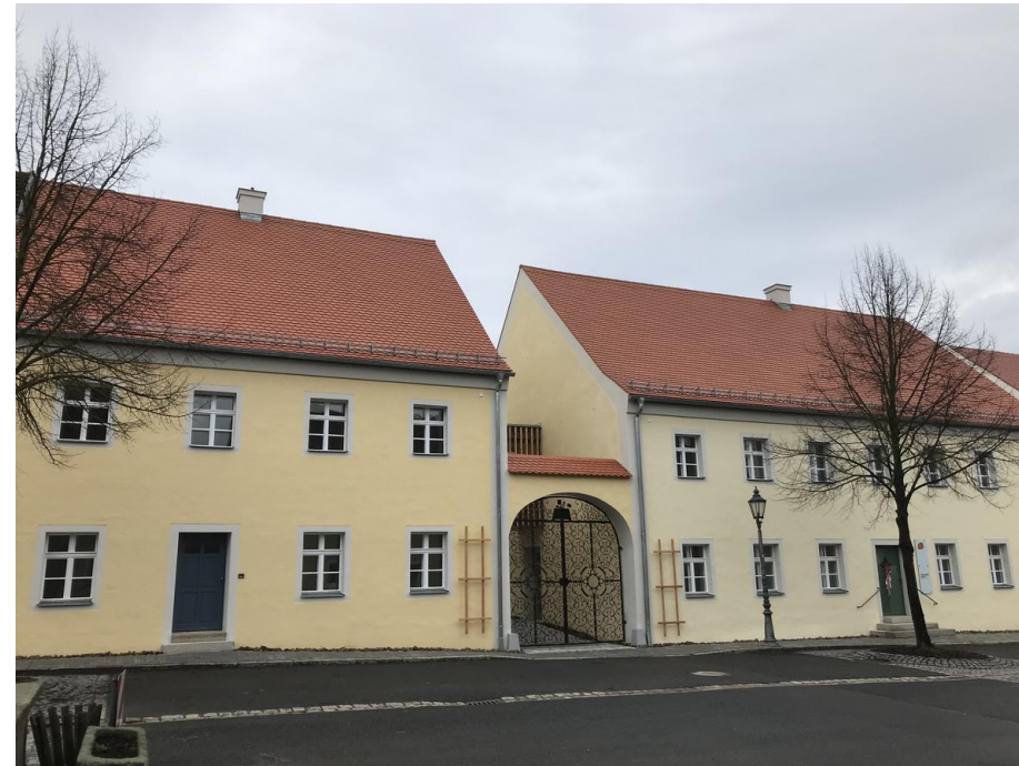
Nach der Sanierung, Wiederherstellung des ursprünglichen Zustands zweier Gebäude
