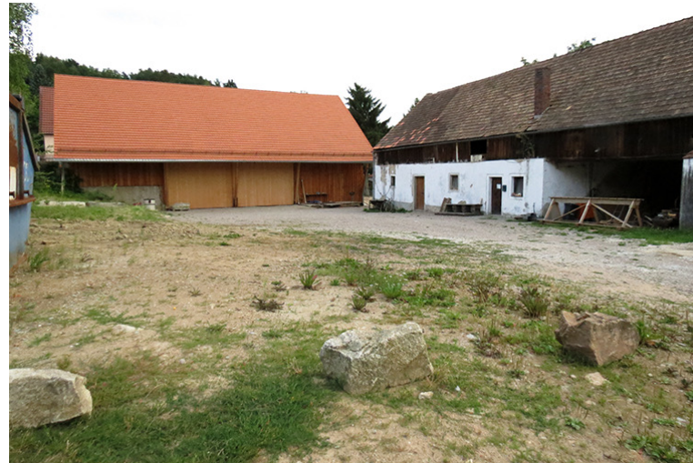
Stadel, saniert und Stall, unsaniert
